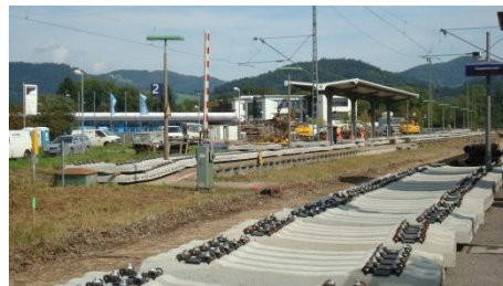
Baustelle Bahnhof Kirchzarten
