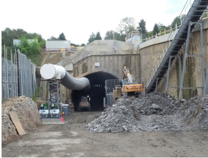
Baustelle des Pforzheimer Tunnels (Foto: Dieter Zaudtke)
