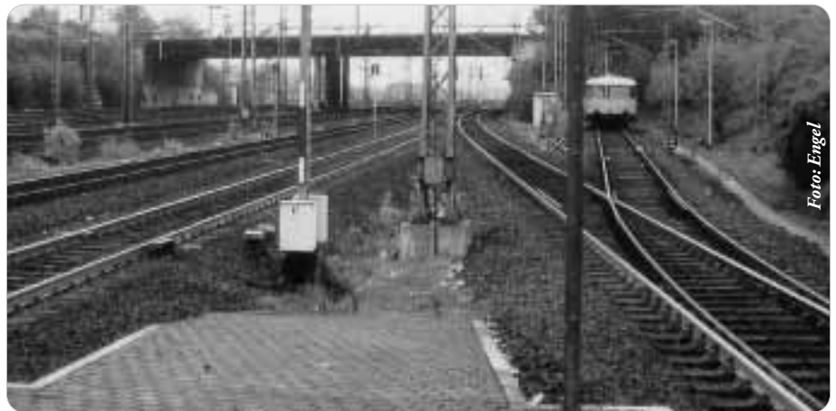
Am Ende des Bahnsteigs fehlen auch in Kassel-Wilhelmshöhe 200 Meter Gleis: Wenn ein Zug abfährt, darf ein anderer nicht oder nur langsam an den Bahnsteig fahren: Die Weiche links liegt im Durchbruchweg, der gesichert werden muss.
